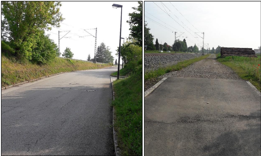
Abbildung 24: aktuelle Zufahrten Parallele zur Landsberger Str. (von Westen – links, von Osten – rechts) (eigene Aufnahme, 18.05.2018)
